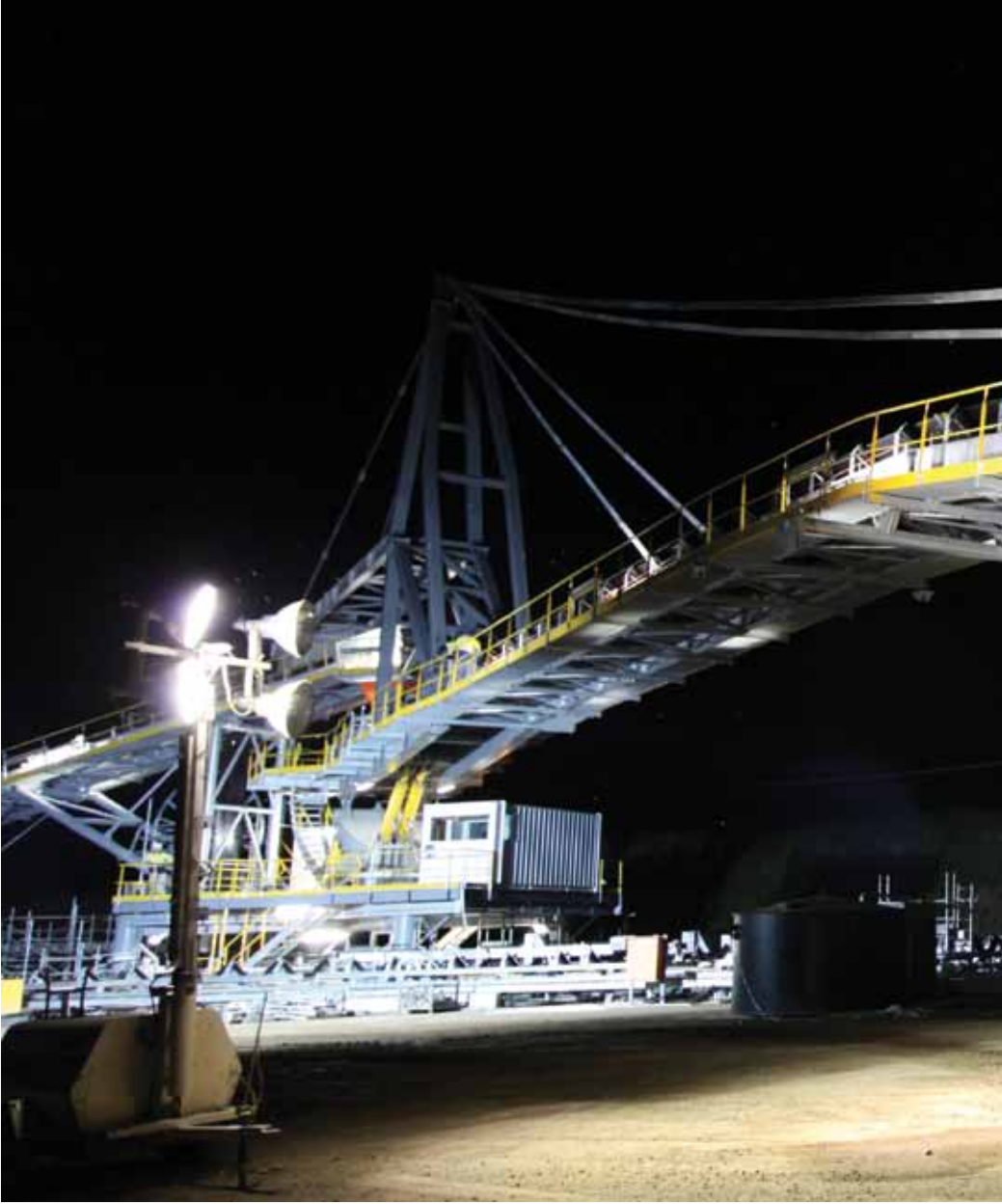
Première production de minerai au pied du Koniambo sur le site de Vavouto.
